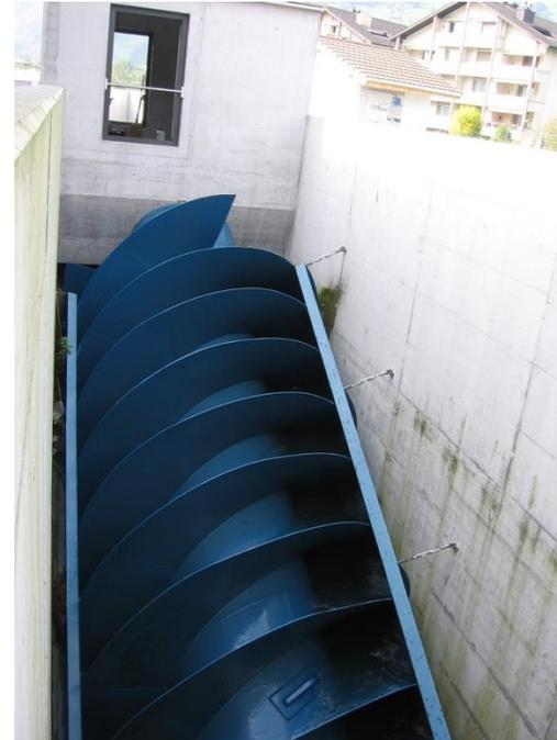
Wasserkraftschnecke Am Aawasser mit einer Leistung von 45 kW resp. nach dem Endausbau 65 kW
